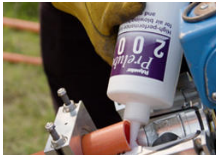
Prelube 2000 appliqué sur un conduit avant de souffler un câble à fibre optique
