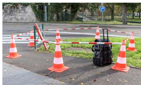
Sécurisation d'une zone large
