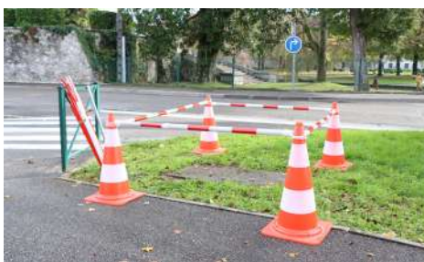
Sécurisation d'une zone étroite
